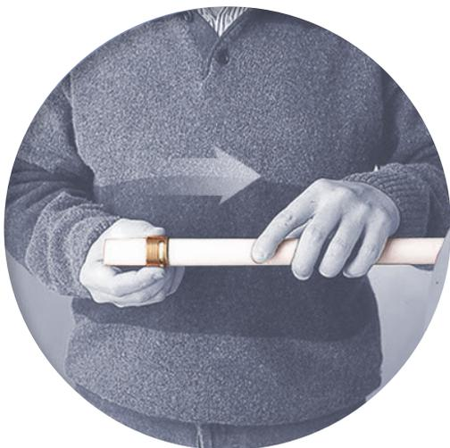
1. Tras efectuar un corte en la tubería limpio y perpendicular a su eje, colocar sobre ésta el casquillo.
