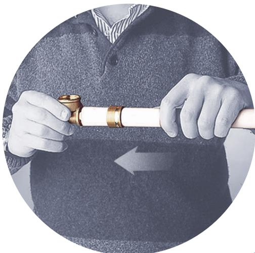
3. Introducir la pieza en la tubería dejando esta a unos 3 mm. de la pared de la pieza.
